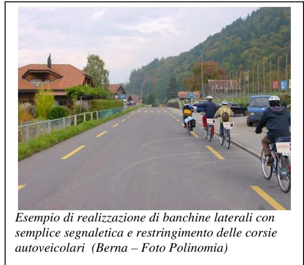
*Esempio di realizzazione di banchine laterali con semplice segnaletica e restringimento delle corsie autoveicolari (Berna – Foto Polinomia)*
